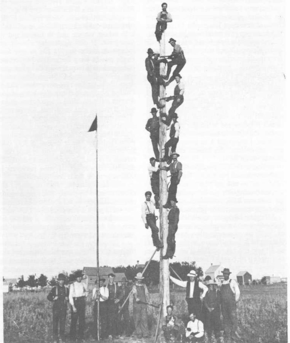
Installation de lignes téléphoniques gouvernementales dans les régions rurales. (Photo: Collection du ministère d'Énergie, mines et ressources – Archives nationales du Canada)
